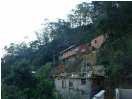
Foto 001 - Deficiência de drenagem e corte inadequado.
